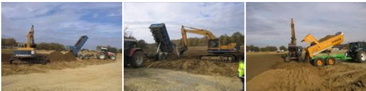
Mise en œuvre des matériaux « à reculons » pour ne pas compacter le matériau mis en œuvre. (photographie réalisée sur la ZAC des Monges à Cornebarrieu, 2006)
