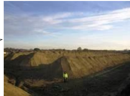
Stockage des matériaux fertiles en andains de section triangulaire. (photographie réalisée sur la ZAC des Monges à Cornebarrieu, 2006)
