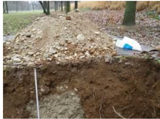
Parc Sud : Transition entre sol superficiel et sol profond ; le tronc de l'arbre le plus proche est à environ 3m de l'extrémité de la fosse (côté droit)
