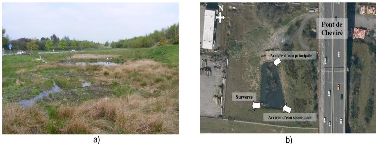
Fig. 1.1 – Les deux bassins de rétention-infiltration : a) le bassin de Boisbonne infiltrant une partie des eaux de ruissellement le long de l'A11 ; b) le bassin de Cheviré suivi depuis 1993 par GER-Ifsttar
